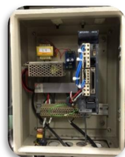
ภาพที่ 5 ตู้คอนโทรลของระบบควบคุม AC Servo Motor
