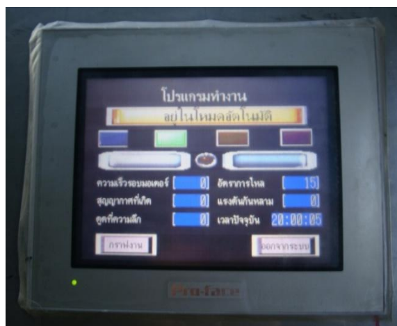
ภาพที่ 3.24 ภาพหลังจากการติดตั้งพีแอลซีแล้ว
