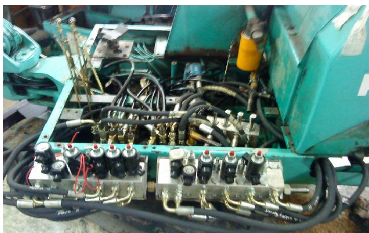
ภาพที่ 4.2 การติดตั้งพอร์ชันนัลแล้วเข้ากับระบบเดิม
