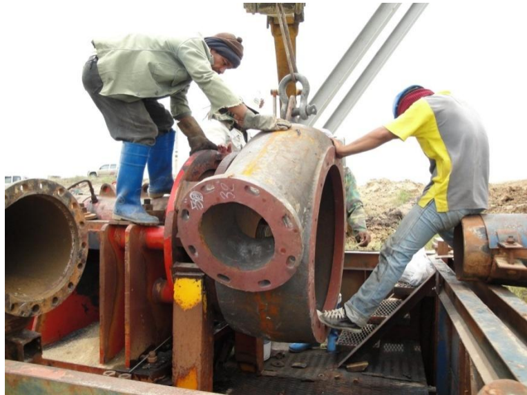
ภาพที่ 4.6 แสดงรูปติดตั้งปั๊มคูตราชขนาด 32 นิ้ว
