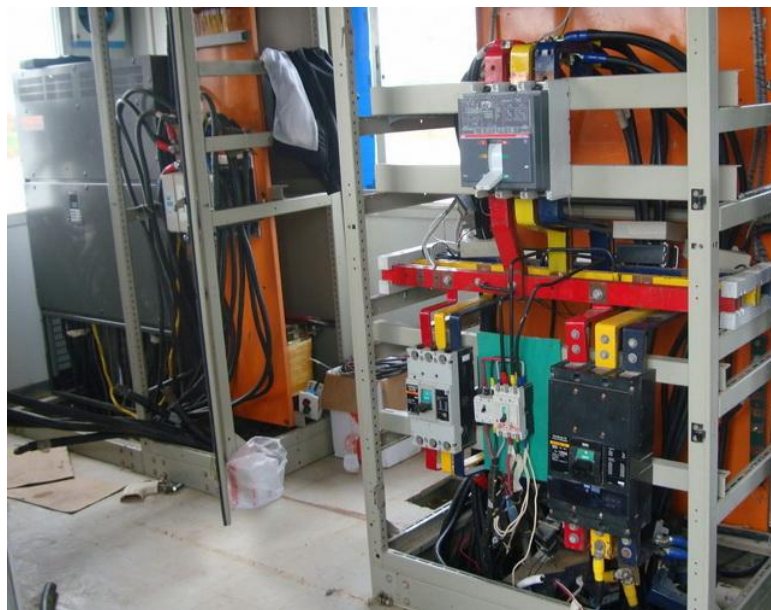
ภาพที่ 4.7 แสดงการติดตั้งอุปกรณ์ควบคุมมอเตอร์
