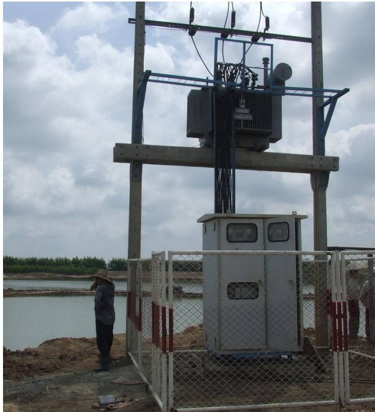
ภาพที่ 4.1 แสดงการติดตั้งหม้อแปลงขนาด 1000 เควีเอ
