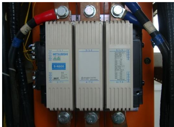
ภาพที่ 4.9 แมกเนติกส์คอนแทคเตอร์ ขนาด 1000 แอมป์
