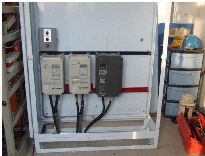
ภาพที่ 4.11 ตำแหน่งของอินเวอร์เตอร์มอเตอร์ ก๊วนกันเซ หลังการปรับปรุง
