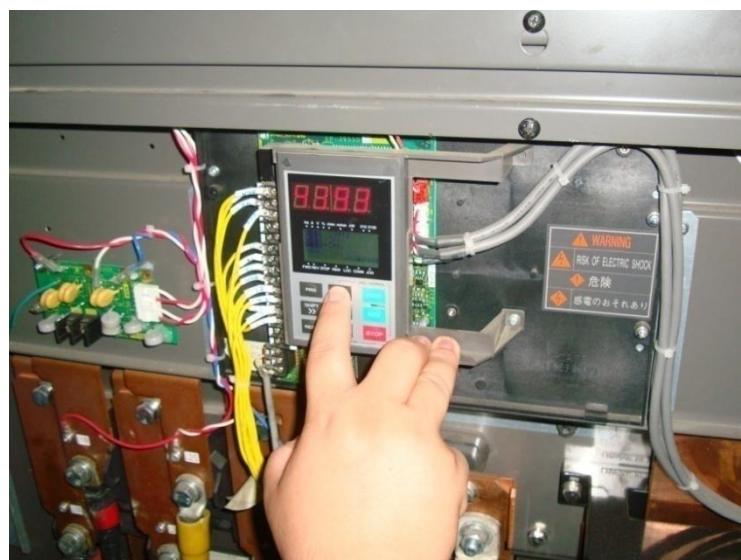
ภาพที่ 4.12 การใส่ค่าพารามิเตอร์มอเตอร์ในอินเวอร์เตอร์
