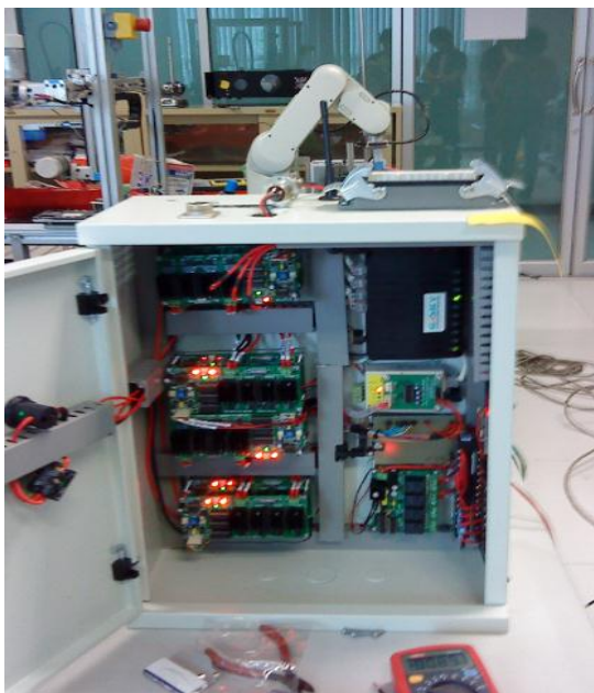
ภาพที่ 3.35 การประกอบตู้ควบคุม
