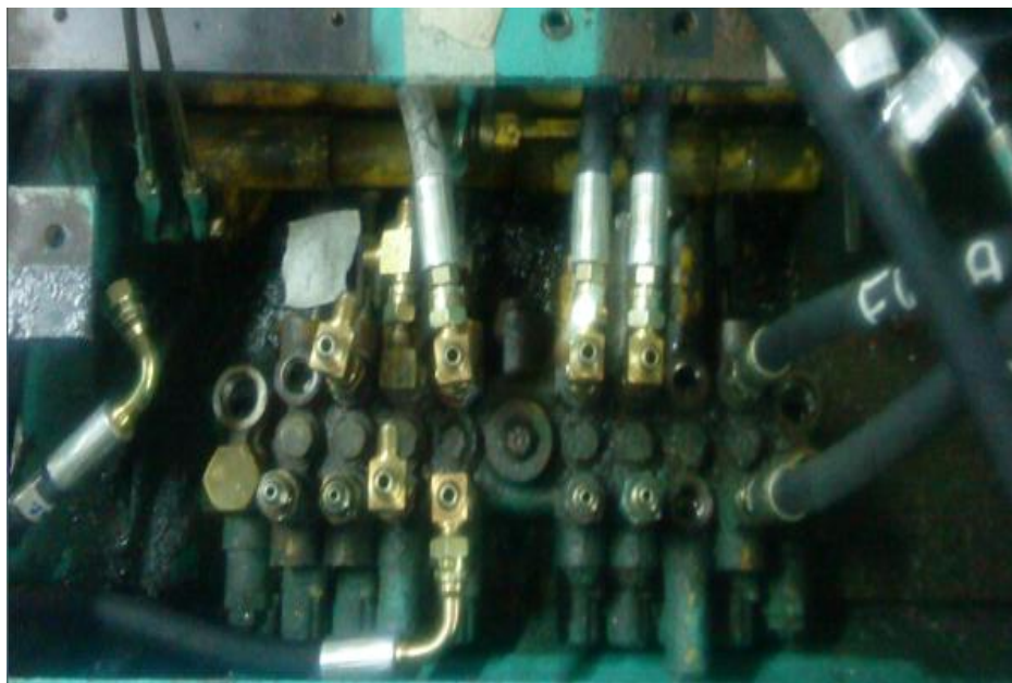
ภาพที่ 3.30 ส่วนของการติดตั้งข้อต่อสามทาง
