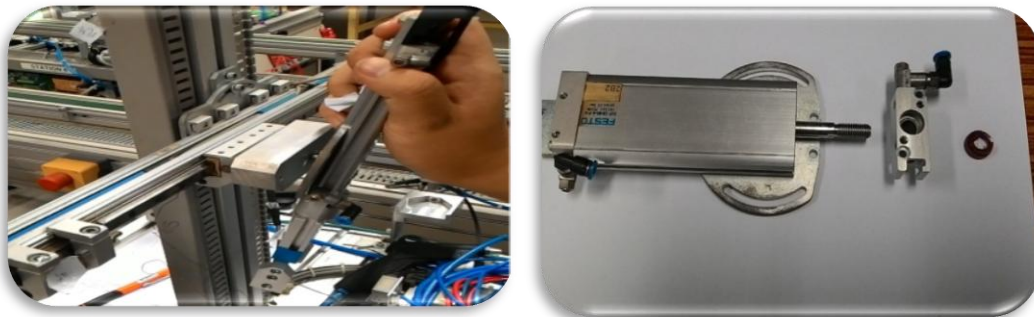
ภาพที่ 3-9 สภาพความเสียหายของสถานีขนถ่ายชิ้นงาน
